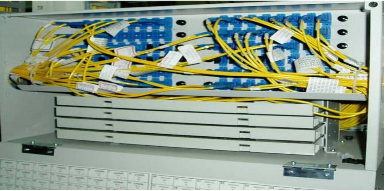
圖 13-3 用戶光纜配線箱圖（一）
